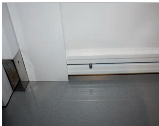
Fijación del perfil mediante pasadores
