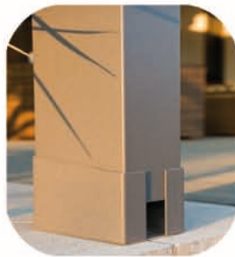
Pendiente mínima para el desagüe.
