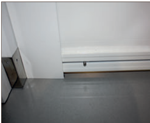
Fijación del perfil mediante pasadores
