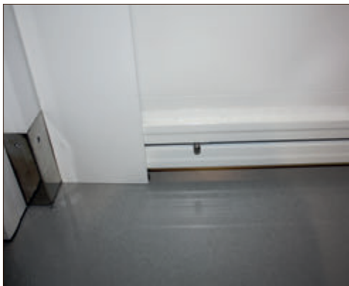
Fijación mediante pasadores
