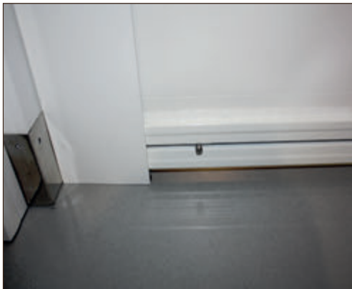
Vérouillage des guides par tirettes
