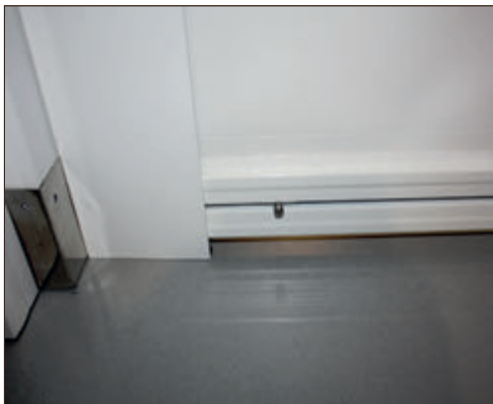
Fijación del perfil mediante pasadores
