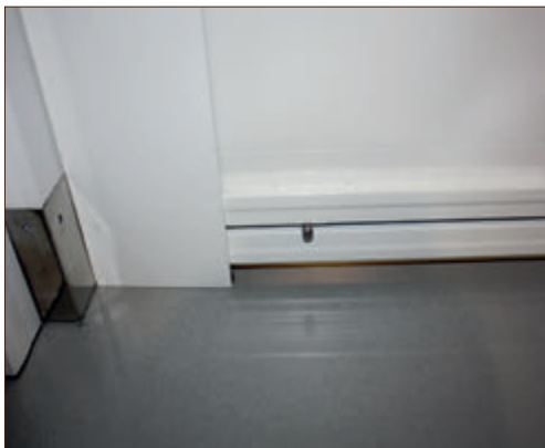
Fijación mediante pasadores
